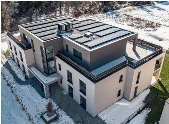
Beim MFH «Ob a Damm» in Chur wird die Terrasse mit dem Orkanet Überwachungssystem überwacht.
