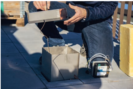
Das Orkanet Flachdachüberwachungssystem ist eine aktive und flächendeckende Überwachungstechnologie, die auf der Dachfläche installiert wird.
