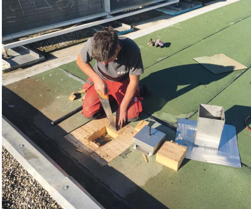
Erstellen eines Dachdurchgriffs für die Sensorbox. Die Abdichtung wird anschliessend fachgerecht wiederhergestellt.
