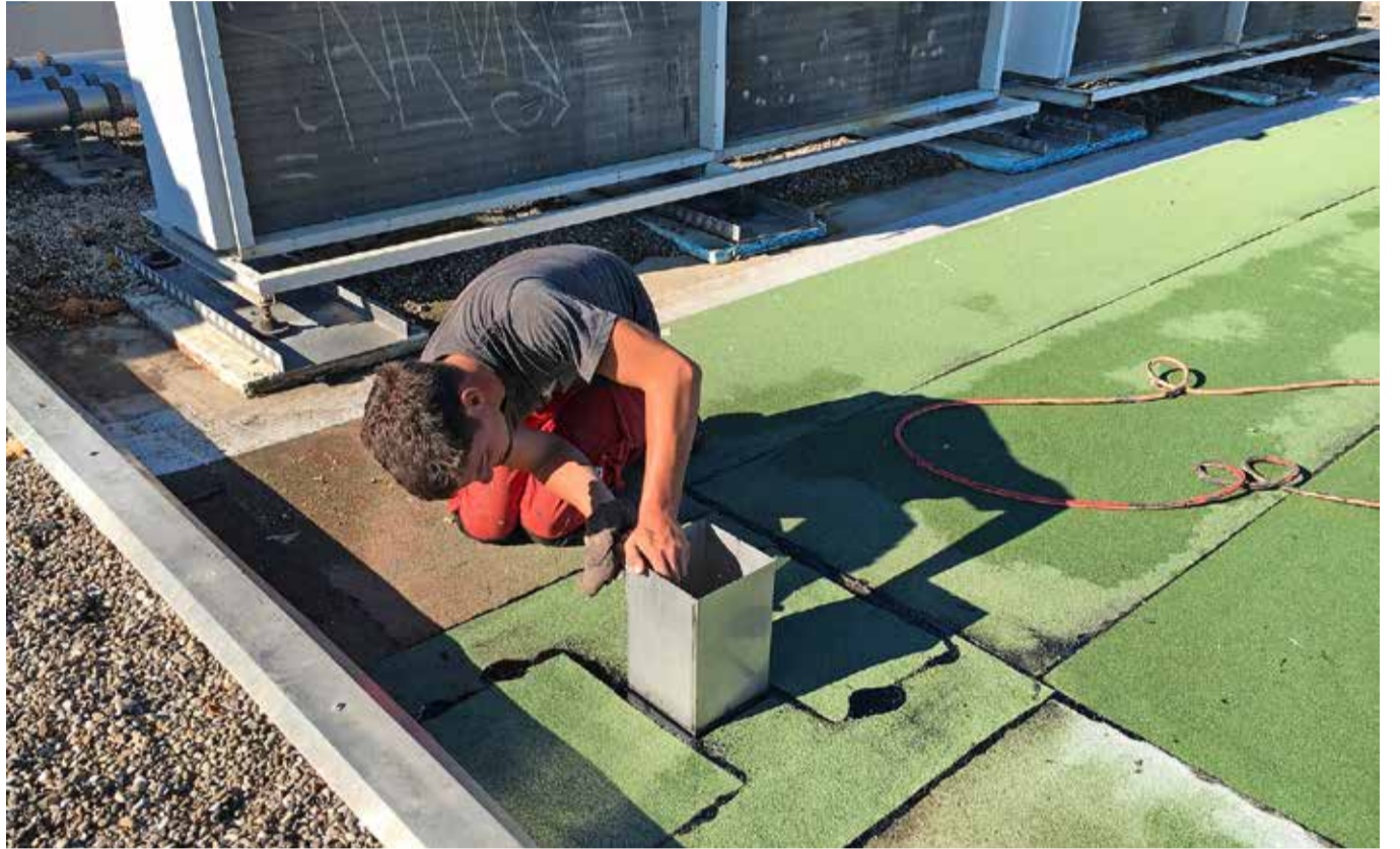
Montage des Dachdurchgriffs auf einem Flachdach. In diesem «Kamin», der in den Dachaufbau hineinreicht, wird später die Orkanet-Sensorbox platziert.
