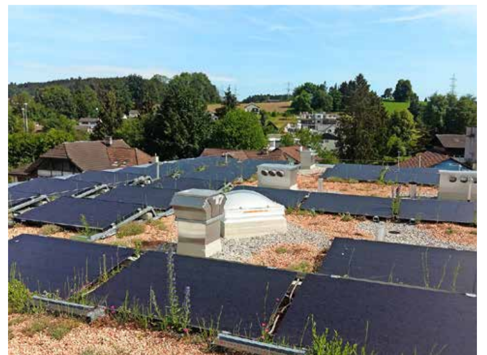
Auf den Dächern von Neubauten wird es eng: Photovoltaik- und Solarthermiepanels, Oberlichter und Lüftungsanlagen einer Siedlung in Obfelden ZH.
